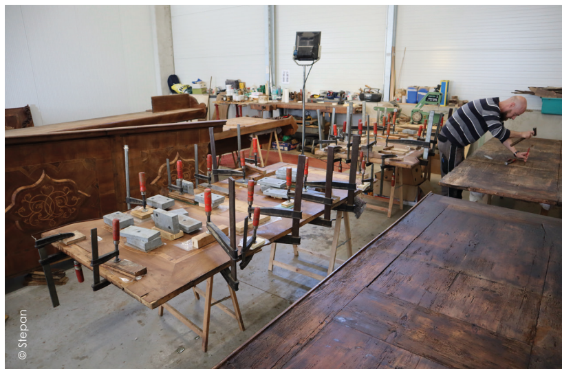
Restaurierung des Laiengestühls
