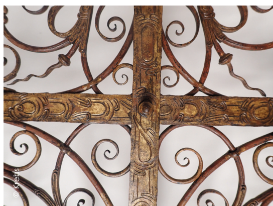
Restauriertes Eisengitter der Kreuzkapelle mit Originalfarbe
