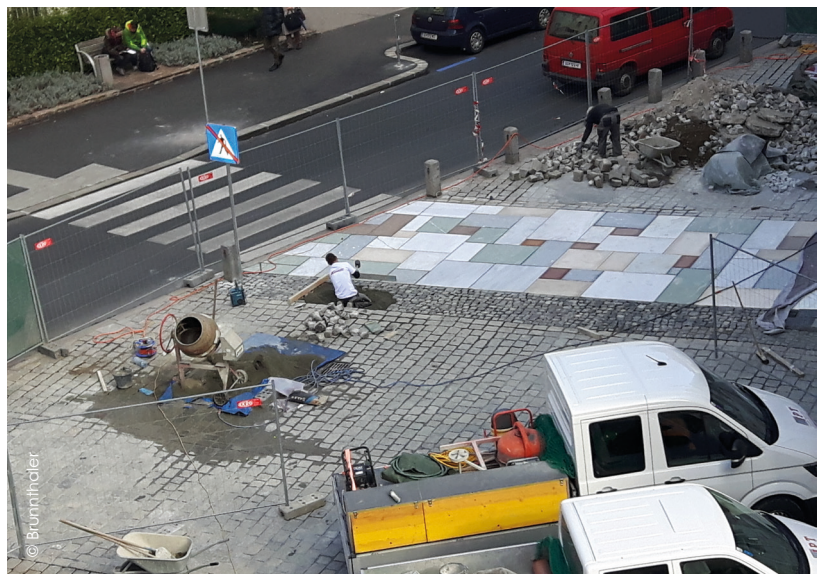
Errichtung der Außenrampe zur Hofgasse im Jahr 2017
