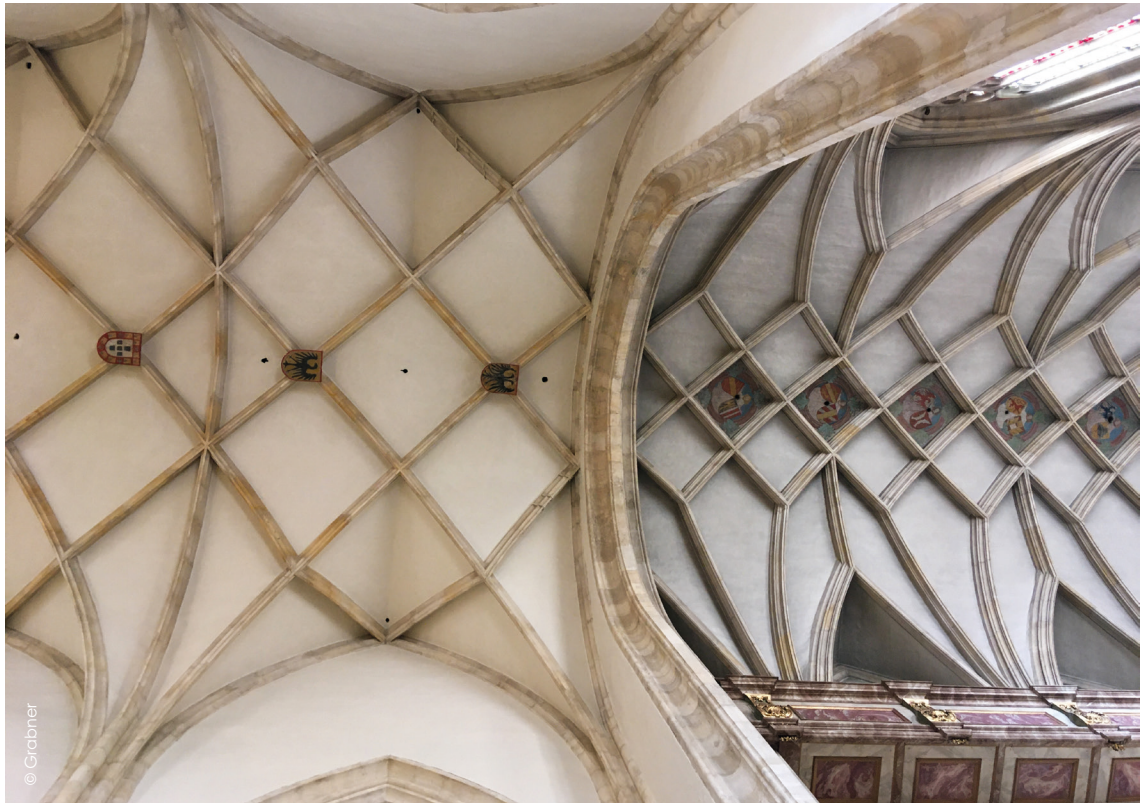
Gewölbe Hauptschiff gereinigt, Presbyterium ungereinigt
