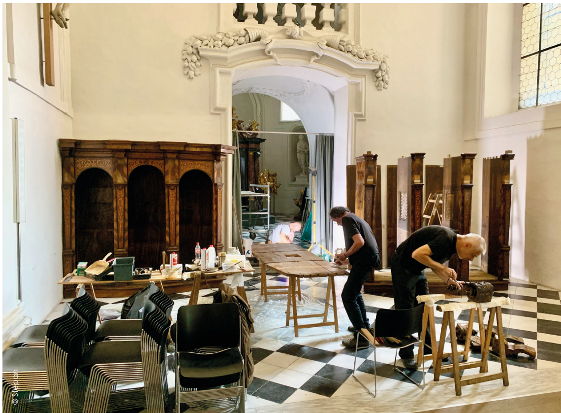
Aufbau der Beichtstühle zum Eingang des Mausoleums
