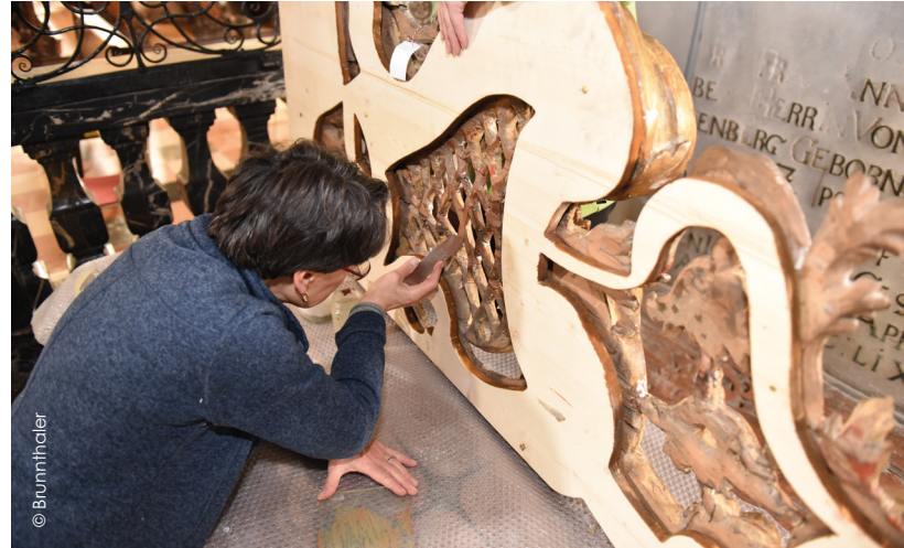
Aufsatz des Chorgestühls bei der Restaurierung
