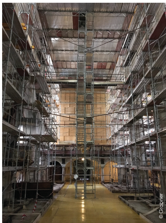
Gerüst im Hauptschiff
