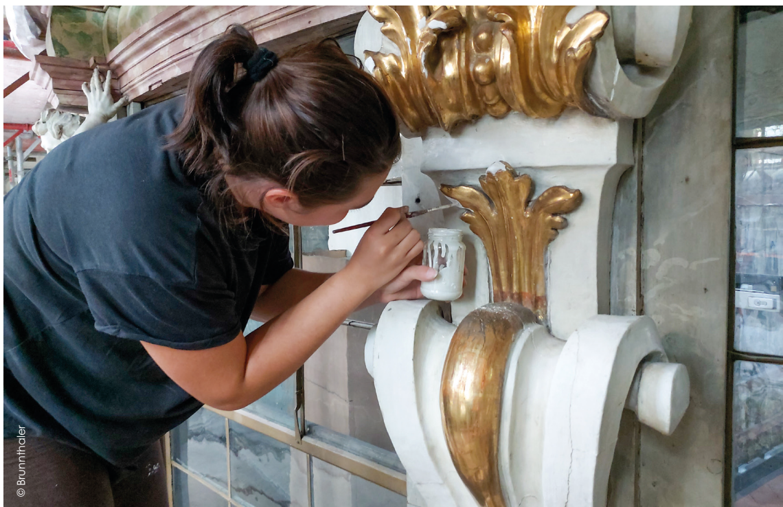
© Brunnthaler Restaurierung der Kaiserempore
