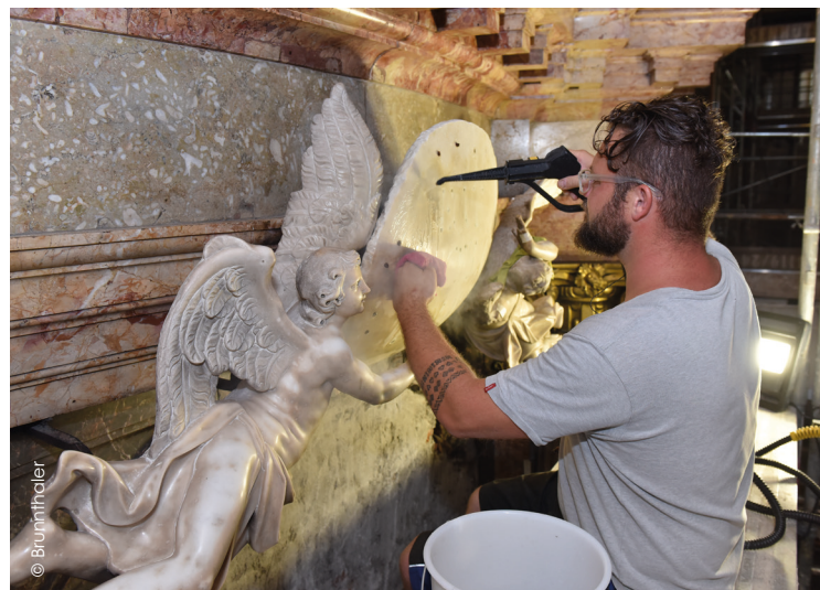
Reinigungsarbeiten mit Wasserdampfstrahl
